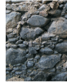
φωτ. 128: πετρόχτιστη ανεπίχριστη τοιχοποιία με συνδετικό υλικό τον πηλό
