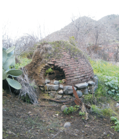
φωτ. 111: Ξυλόφουρνος με κύριο υλικό τουβλάκι
