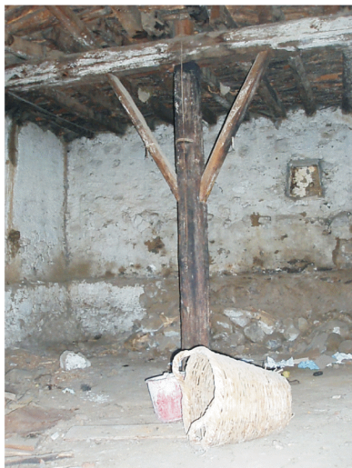
φωτ. 119: δίκωρο διαχωρισμένο με νευκά, ενισχυμένη με μεσοδότση οροφή: σειρά από βολιτζία, κλαδιά και φύλλα
