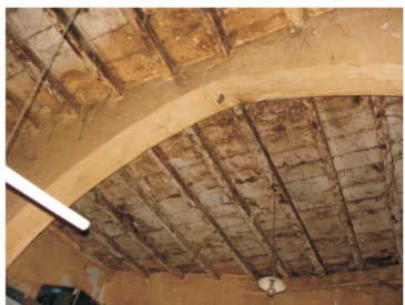
φωτ. 120: δίκωρο διαχωρισμένο με διπλομούρελλη καμάρα, οροφή: σειρά από μορίνες και σανίδες από ξύλο
