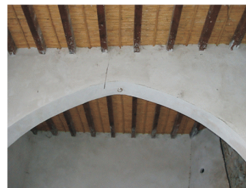
φωτ. 122: δίκωρο διαχωρισμένο με διπλομούρελλη καμάρα οροφή: σειρά από μορίνες και καλάμια
