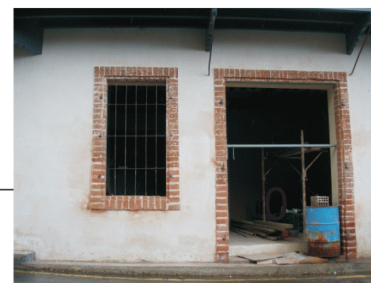
φωτ. 68: Πλαίσιο παραθύρων και πόρτας ισόγειου από κόκκινο τούβλο
