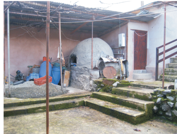
φωτ. 112: Ξυλόφουρνος με κύριο υλικό τουβλάκι καλυμμένο με τσιμέντο
