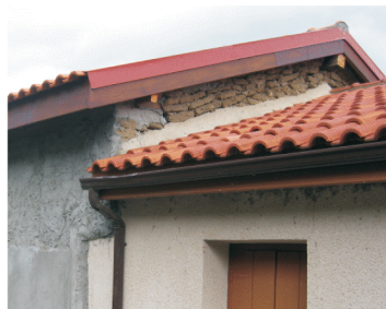
φωτ. 47: Νέα κεραµιδосκεπή
