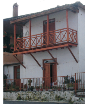
φωτ. 97: αποκατεστημένα ξύλινα μπαλκόνια με σπάνια τυπολογία χιαστή στοιχείων,
