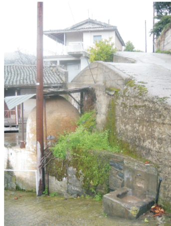
φωτ. 110: Ξυλόφουρνος με κύριο υλικό τουβλάκι καλυμμένο με πηλό
