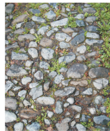
φωτ. 131: οδόστρωση – πέτρα ποταμού
