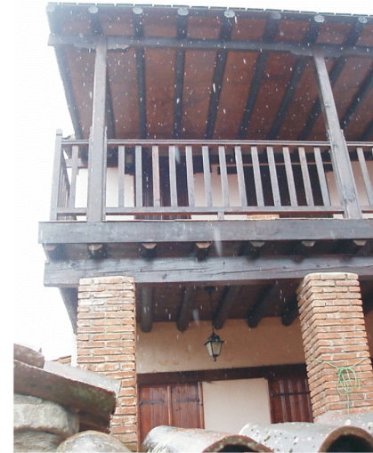
φωτ.58: Σημερινή κατάσταση οικοδομής
