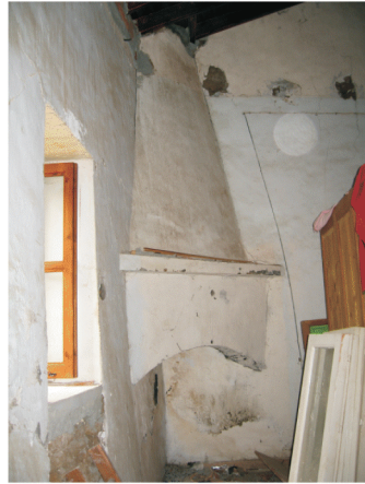
φωτ. 107: χτιστή εστία από τουβλάκι καλυμμένη με ασβέστη
