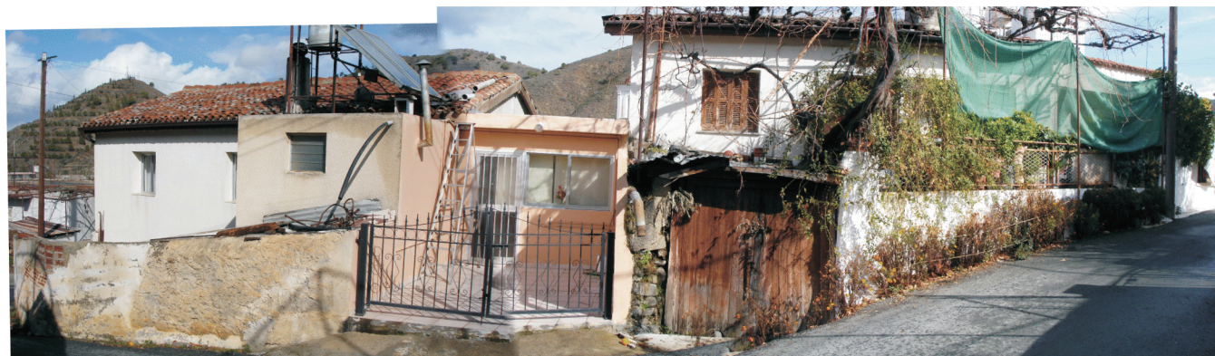
φωτ. 35: Σύγχρονη οικοδομή σε συνεχόμενη δόμηση με παραδοσιακό κτίσμα. Το δεύτερο δύσκολα εντοπίζεται ως δείγμα παραδοσιακής αρχιτεκτονικής, λόγω των πολλαπλών στρωμάτων επέμβασης, κυρίως στις όψεις του. Δυσμενής είναι και η σχέση του με τον δρόμο, λόγω της ασφαλτρώστρωσης.
