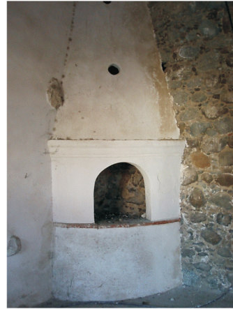
φωτ. 108: χτιστή εστία από τουβλάκι καλυμμένη με ασβέστη
