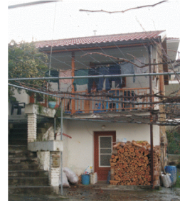
φωτ. 48: Νέο μπαλκόνι
