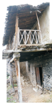
φωτ. 96: σπάνια τυπολογία ξύλινων μπαλκόνιων, με χιαστή στοιχεία, με πέτρινη σκάλα στον ηλιακό
