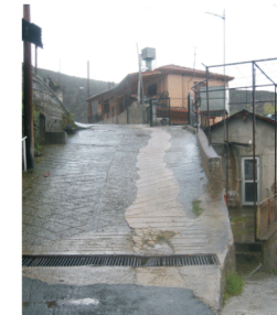
φωτ.54 :Δρόμος προσβάσιμος από αυτοκίνητα.
