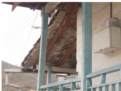
φωτ. 123: στέγαση ηλιακού με σειρά από μορίνες και ψάθα
