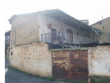
φωτ. 49: Νέος µαντρότοιχος
