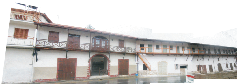
φωτ. 27: Χάνι: Σήμερα ανήκει εξ' αδιακρίτου σε ιδιώτες, και έχει ανακαινιστεί κατά το ήμισι. Είναι και αυτό ενταγμένο στο πρόγραμμα αποκατάστασης των μπαλκονιών που έχουν κηρυχτεί αρχαία μνημεία.
