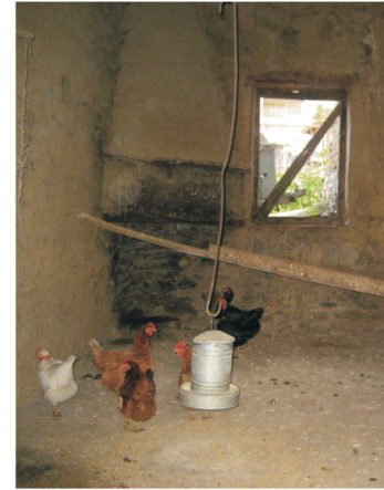
φωτ. 109: χτιστή εστία από τουβλάκι καλυμμένη με ασβέστη
