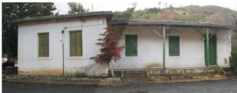
φωτ.29:.. Το δεύτερο σχολείο, κτίσμα του 1919
