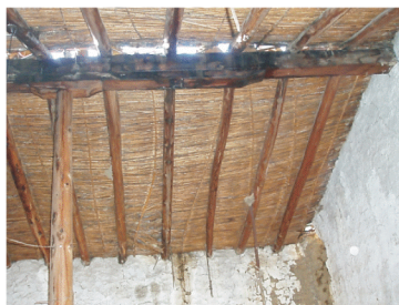
φωτ. 121: δίκωρο διαχωρισμένο με νευκά οροφή: σειρά από βολιτζία και καλάμια
